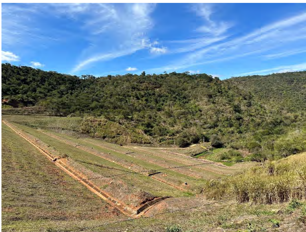
Foto 6 – Talude de jusante – Vista para a ombreira esquerda.
