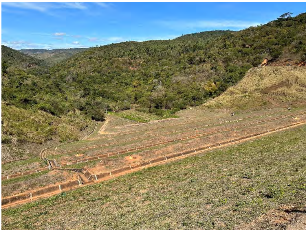
Foto 7 – Talude de jusante – Vista para a ombreira direita.
