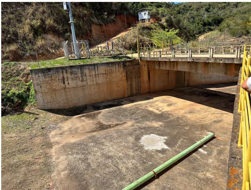
Foto 23 – Canal aproximação do extravasor – ombreira esquerda.
