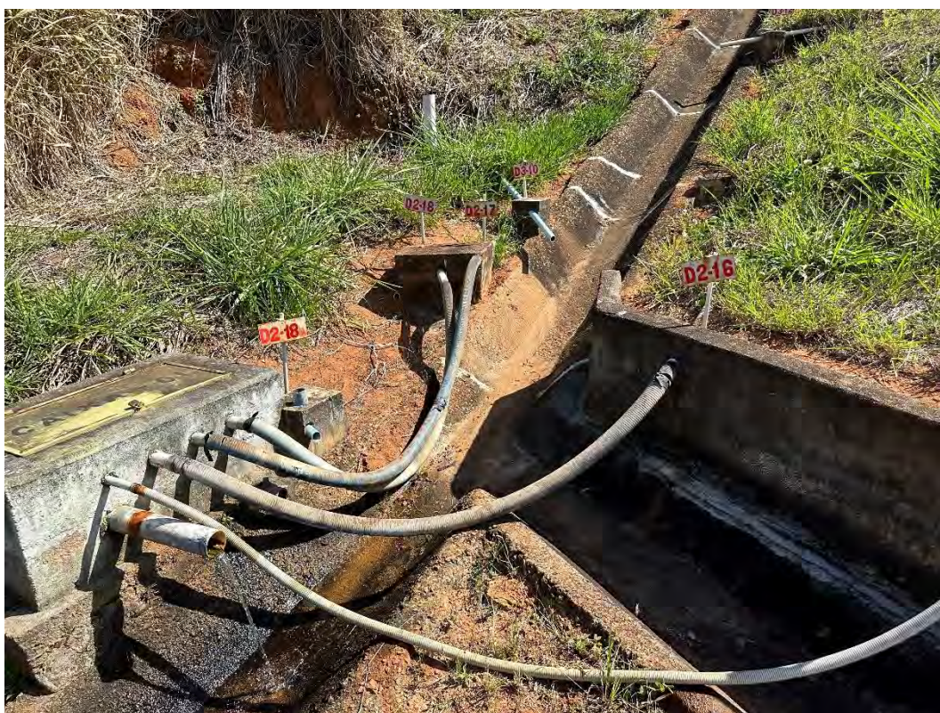
Foto 12 – Drenos horizontais profundos – Berma 510 – Contato com a ombreira esquerda.
