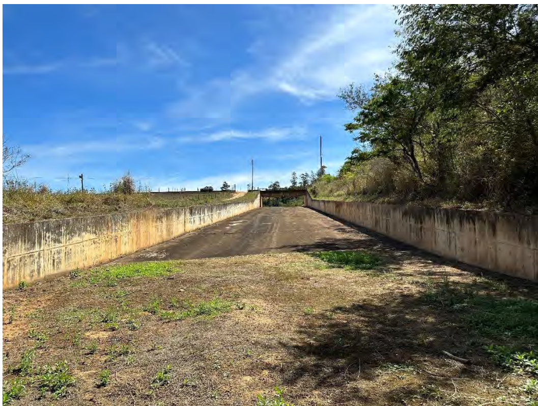
Foto 25 – Canal extravasor – vista para montante – ombreira esquerda.
