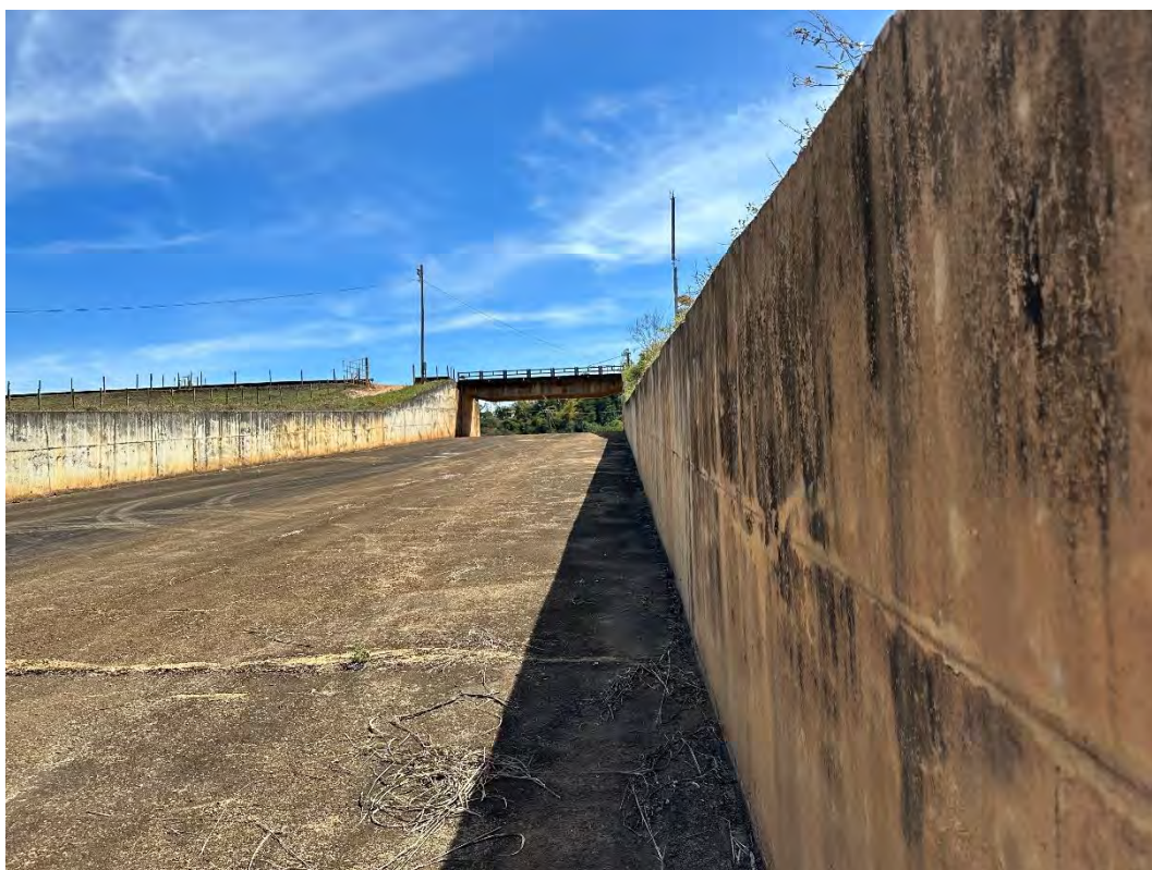
Foto 26 – Estrutura do canal extravasor sem avarias ou sinais de instabilidade.
