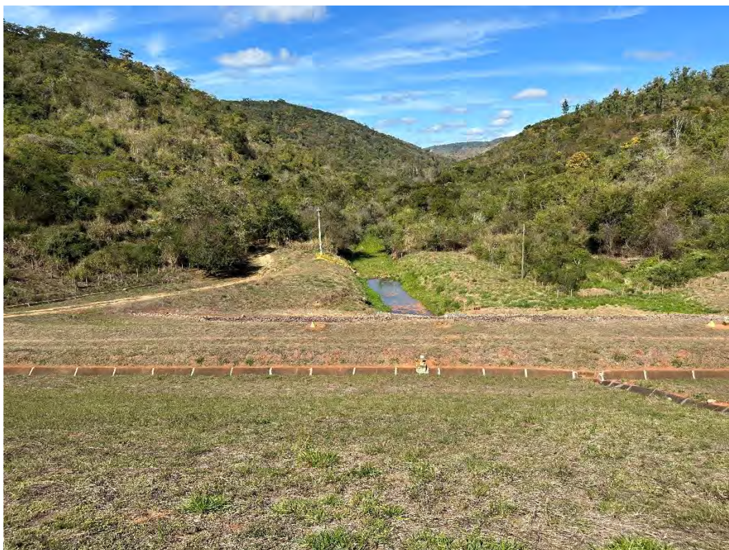
Foto 17 – Área de jusante – Detalhe para a bacia de acumulação do dreno de fundo.
