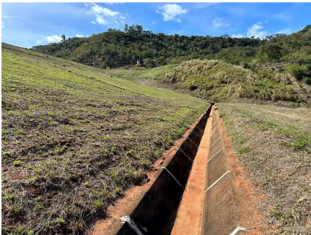
Foto 11 – Talude de jusante – Berma 490 – Vista para a ombreira esquerda.
