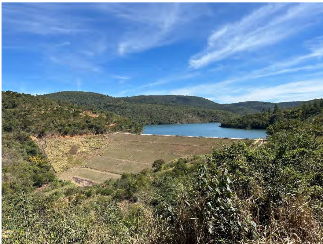
Foto 1 – Vista geral da barragem.
