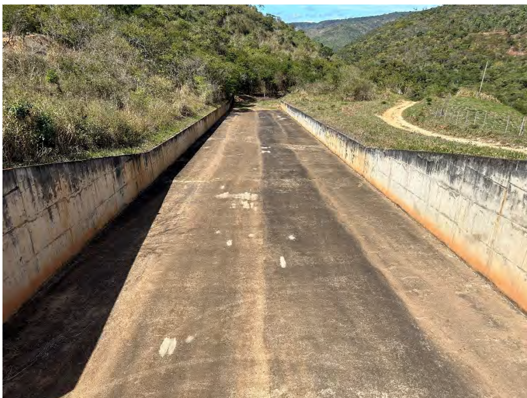
Foto 24 – Canal extravasor – vista para jusante – ombreira esquerda.
