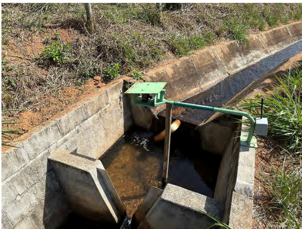
Foto 18 – Dissipação da drenagem superficial da ombreira direita.
