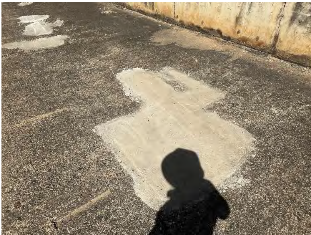
Foto 29 – Antigos reparos realizados sem sinais de deterioração.
