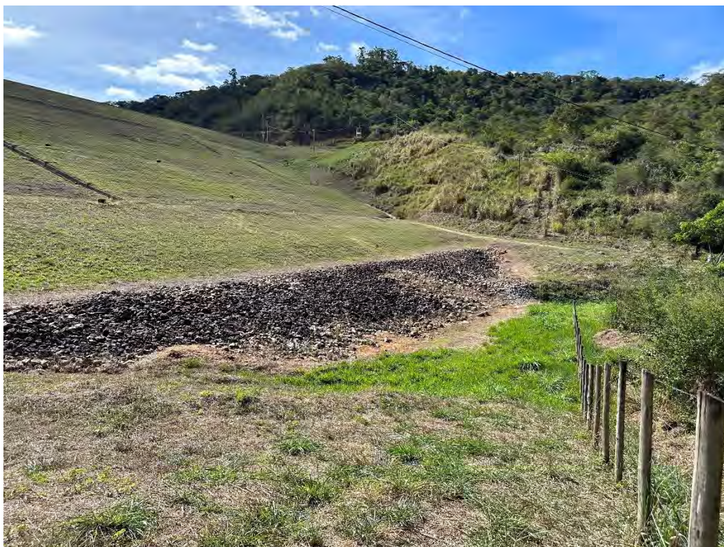
Foto 15 – Talude de jusante – Enrocamento de “pé”. – Vista para a ombreira esquerda.
