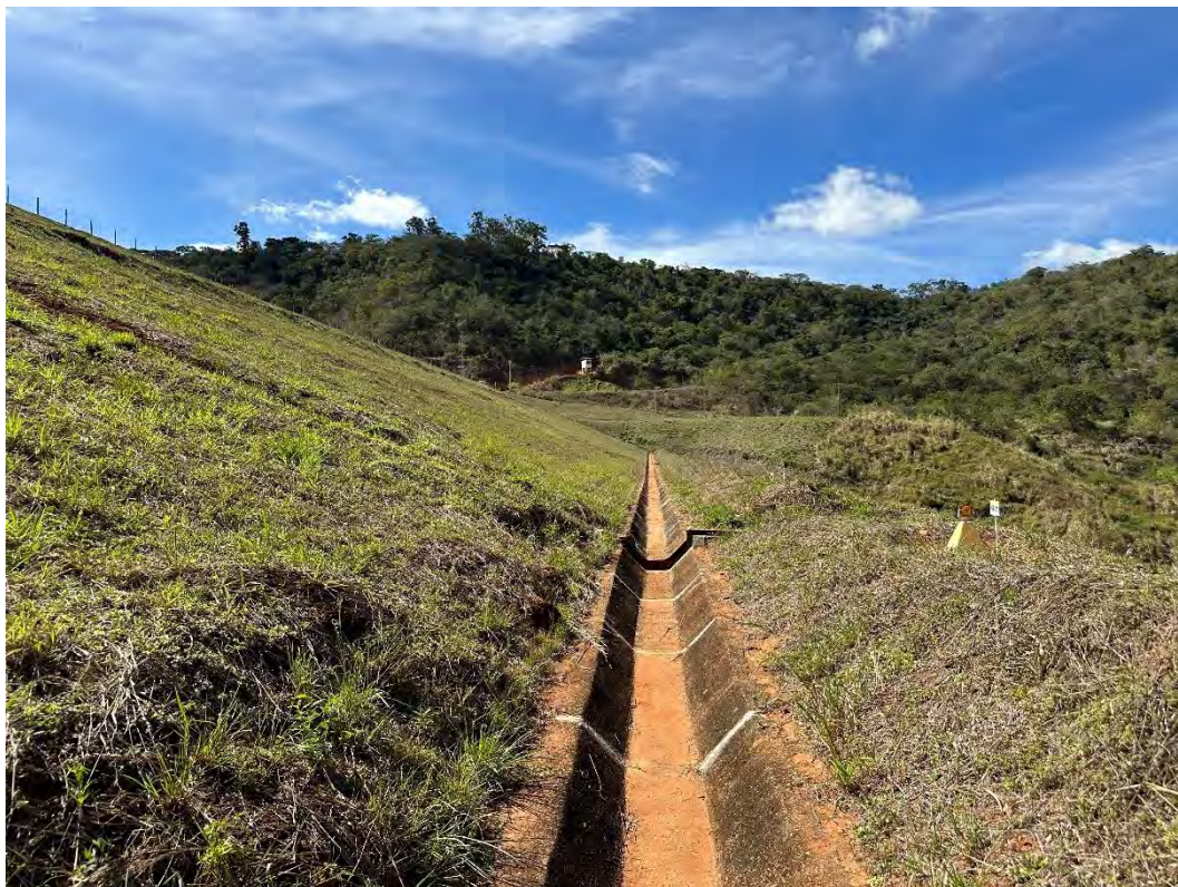
Foto 9 – Talude de jusante – Berma 510 – Vista para a ombreira esquerda.
