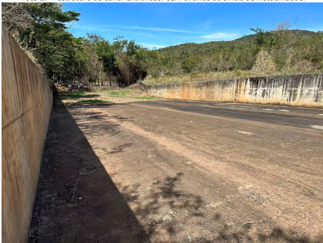
Foto 28 – Estrutura do canal extravasor sem avarias ou sinais de instabilidade.
