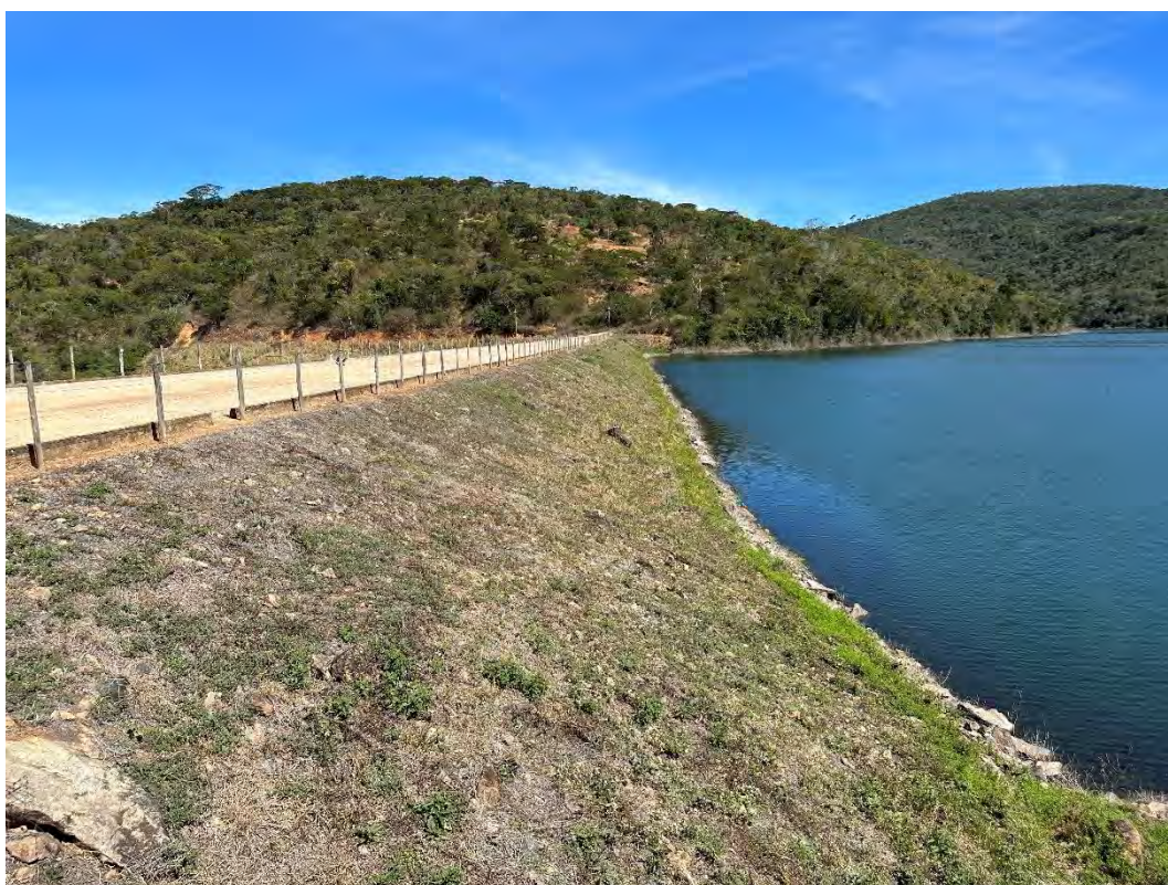
Foto 4 – Talude de montante – Vista para a ombreira direita.
