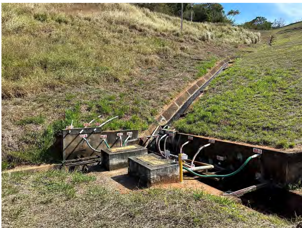
Foto 14 – Drenos horizontais profundos – Berma 490 – Contato com a ombreira esquerda.
