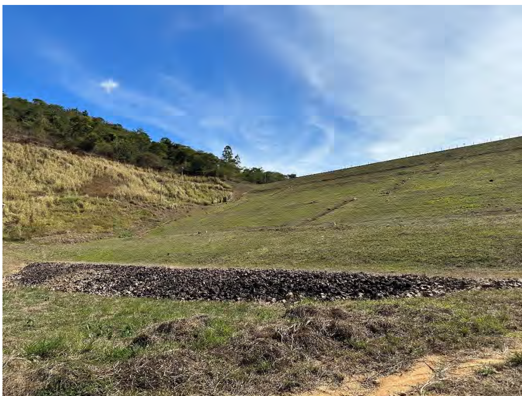
Foto 16 – Talude de jusante – Vista frontal.
