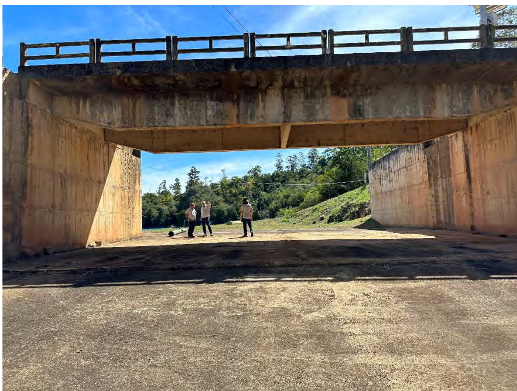
Foto 22 – Emboque do extravasor – ombreira esquerda.
