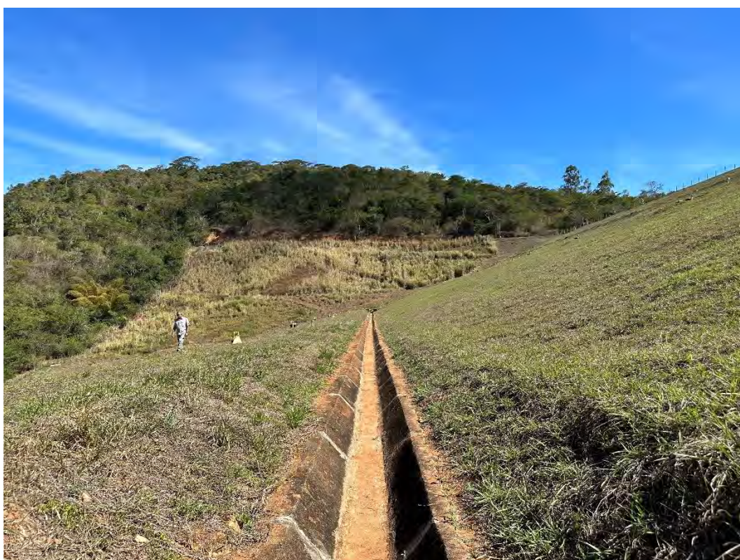
Foto 10 – Talude de jusante – Berma 500 – Vista para a ombreira direita.
