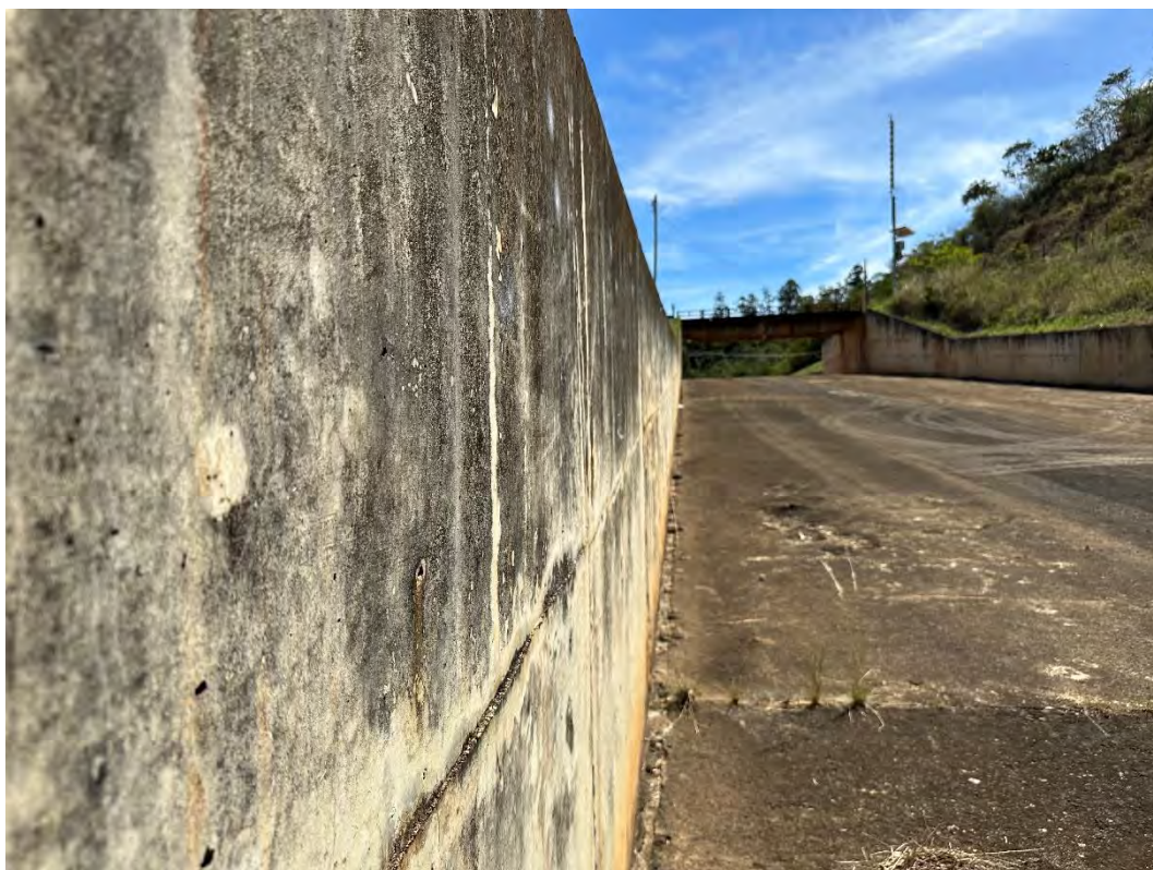
Foto 27 – Estrutura do canal extravasor sem avarias ou sinais de instabilidade.
