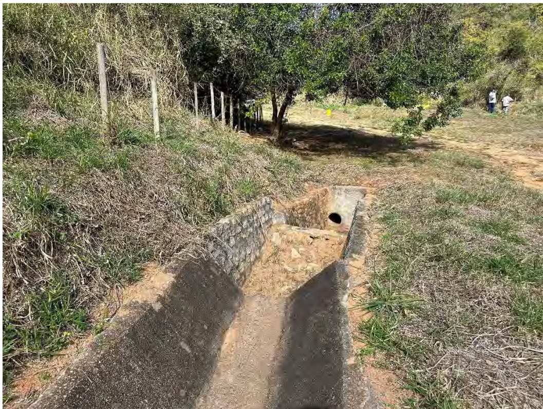
Foto 19 – Dissipação da drenagem superficial da ombreira esquerda.
