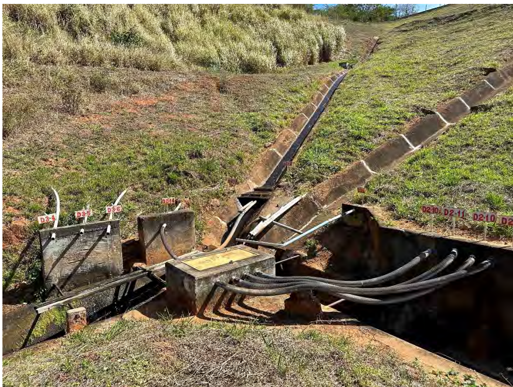
Foto 13 – Drenos horizontais profundos – Berma 500 – Contato com a ombreira esquerda.
