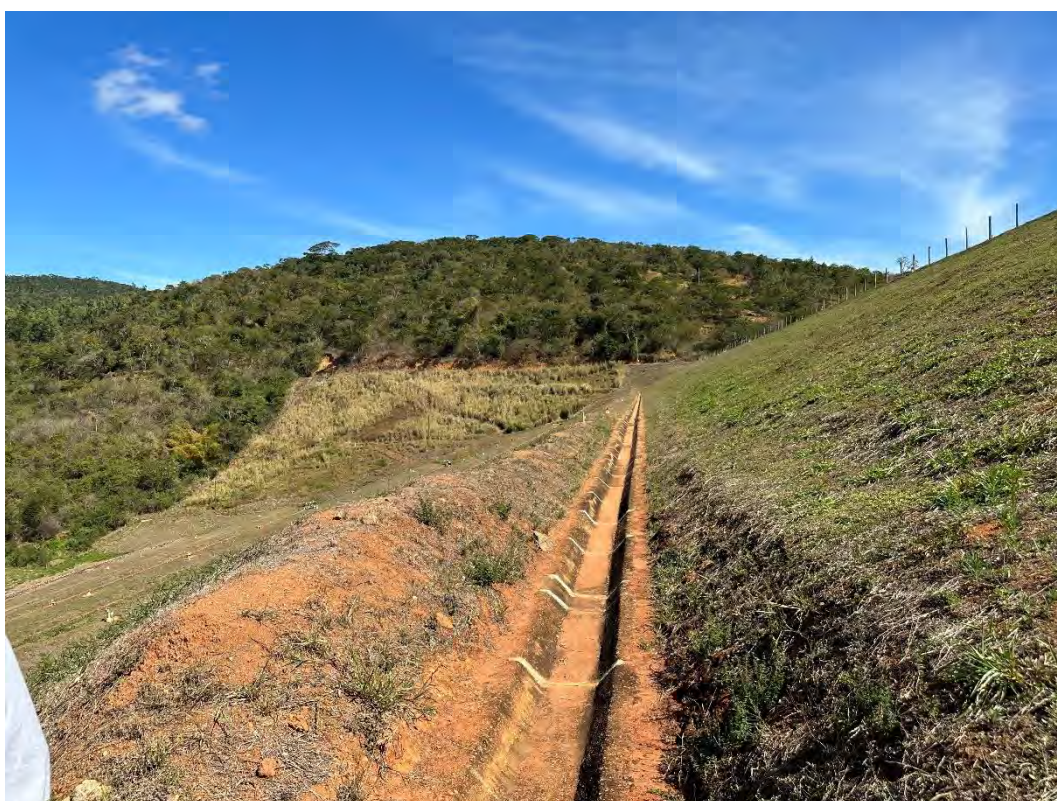
Foto 8 – Talude de jusante - Berma 520 – Vista para a ombreira direita.
