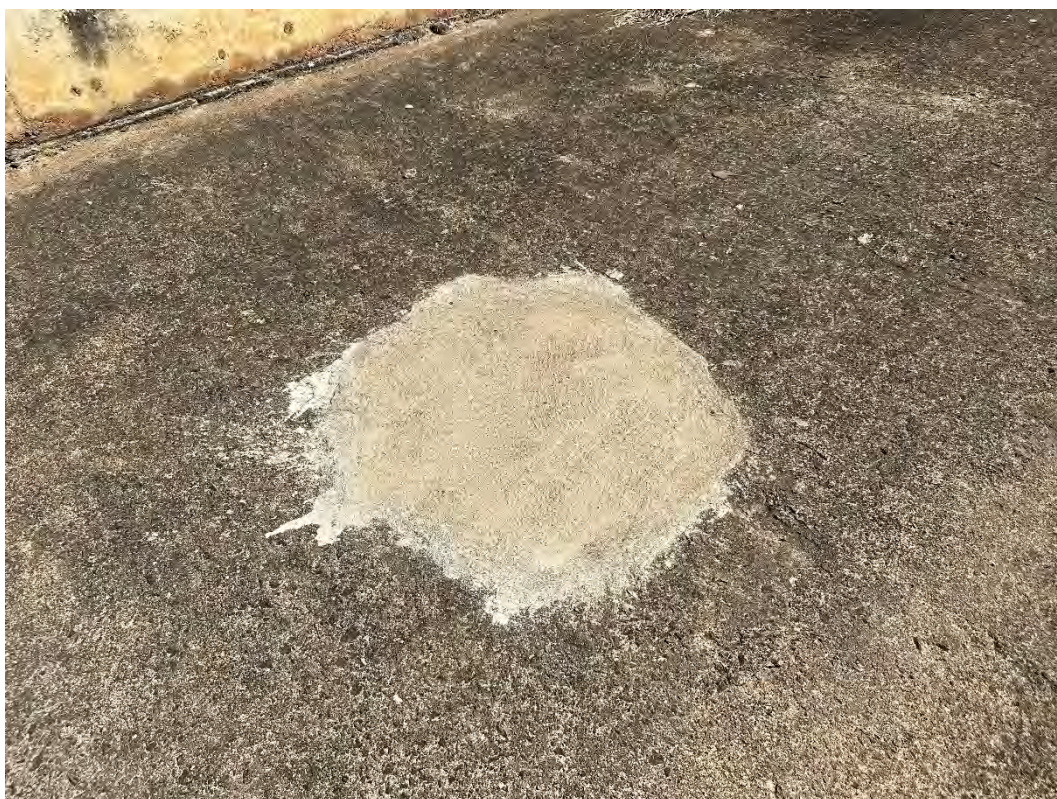
Foto 30 – Antigos reparos realizados sem sinais de deterioração.
